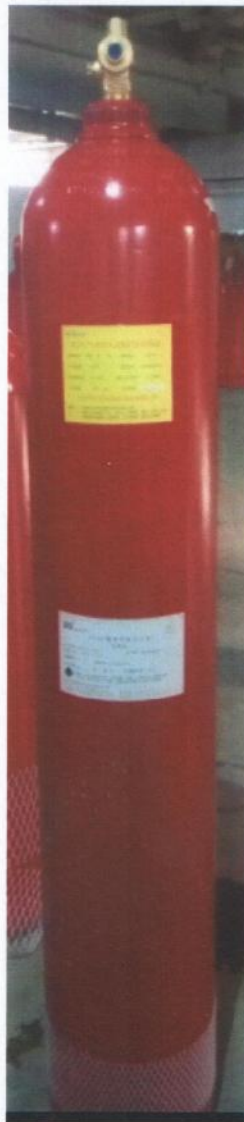
IG541 气体灭火设备灭火剂瓶组 HMP80/15
